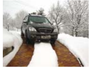
Nyomsáv fűtés térkő burkolatban
